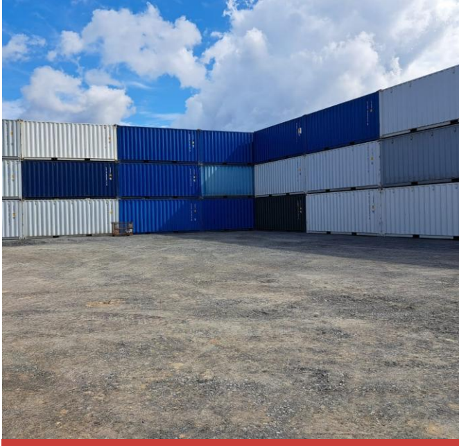
Dreilagige Container-Lärmschutzwand auf einer Großbaustelle - Ansicht 1
