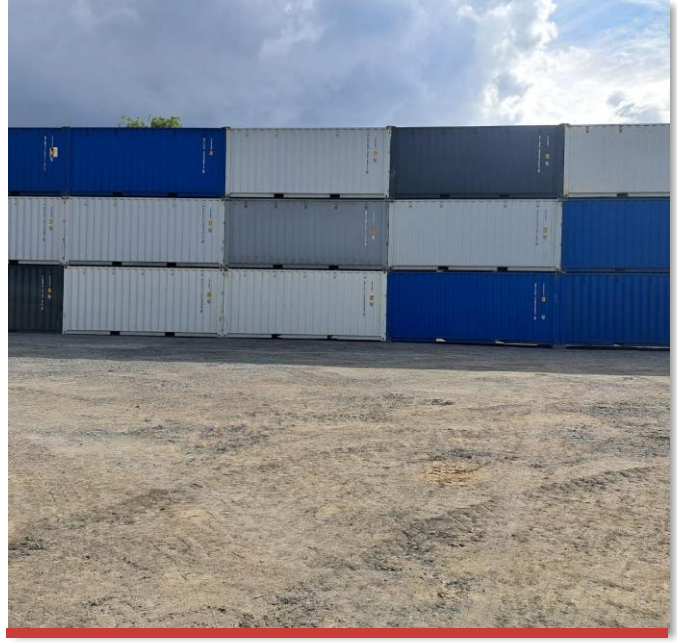
Dreilagige Container-Lärmschutzwand auf einer Großbaustelle - Ansicht 2
